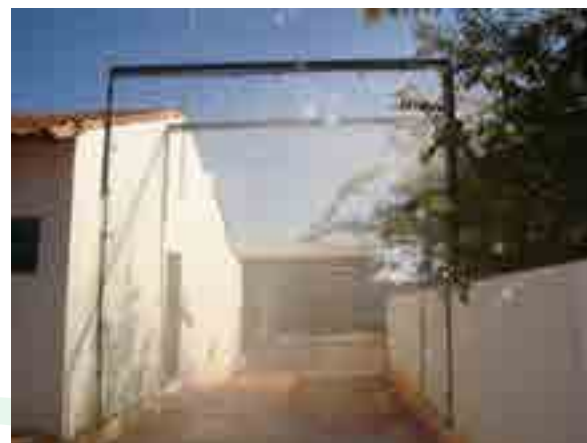
Foto 3 – Arco de desinfecção de veículos
