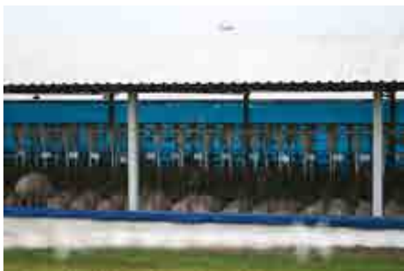
Foto 7 – Tela de proteção dos galpões
