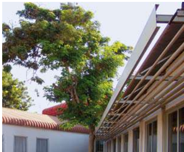
{ FIG. 3.22 } Utilização de vegetação e dispositivos fixos para sombreamento, no edifício da Faculdade de Arquitectura da UAN, Luanda
