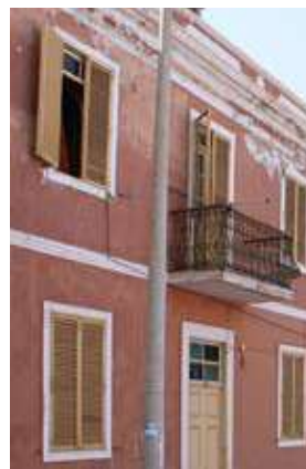
{ FIG. 3.35 } Portadas exteriores de duas casas, além de sombreamento, permitem e direccionam o fluxo de ventilação natural.
