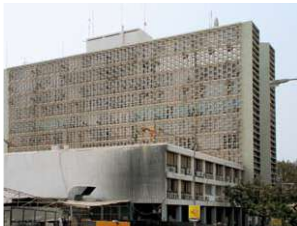
{ FIG. 3.15 } Utilização de dispositivos fixos para sombreamento ("Brise soleil"), num edifício modernista em Luanda.
