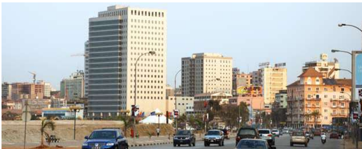
{ FIG. 1.4 } Nova construção: reabilitação das infra-estruturas viárias e edifícios de serviços, Luanda.
