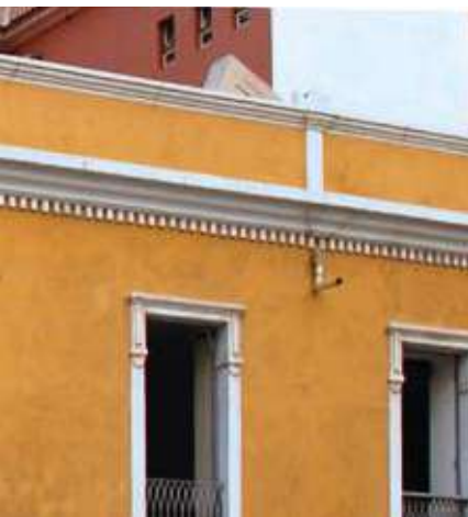
{ FIG. 3.34 } Uma parte significativa dos edifícios residenciais que encontramos nas zonas urbanas mais consolidadas em Luanda têm áreas de envidraçado muito razoáveis. São uma boa referência para o projecto de novos edifícios. A área de envidraçado não deve exceder os 30% da superfície total das fachadas Norte ou Sul, e deve ser devidamente sombreada.
