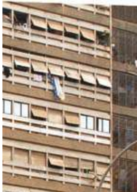
{ FIG. 3.23 } Sombreamento ajustável: portadas venezianas exteriores de madeira (esquerda) e estores (direita): proporcionam sombreamento e simultaneamente permitem iluminação e ventilação natural.
