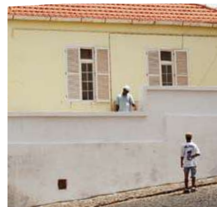
{ FIG. 3.35 } Portadas exteriores de duas casas, além de sombreamento, permitem e direccionam o fluxo de ventilação natural.
