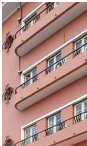
{ FIG. 3.34 } Uma parte significativa dos edifícios residenciais que encontramos nas zonas urbanas mais consolidadas em Luanda têm áreas de envidraçado muito razoáveis. São uma boa referência para o projecto de novos edifícios. A área de envidraçado não deve exceder os 30% da superfície total das fachadas Norte ou Sul, e deve ser devidamente sombreada.
