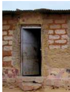
{ FIG. 1.8 } Construção não consolidada em espaço urbano: a edificação é normalmente executada pelo próprio, utilizando recursos locais (auto-construção).
