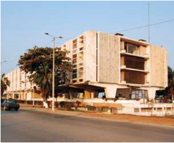
{ FIG. 3.26 } A pintura de cor clara reflecte o calor, evitando o sobreaquecimento no interior dos edifícios.
