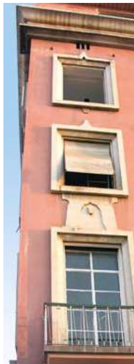
{ FIG. 3.34 } Uma parte significativa dos edifícios residenciais que encontramos nas zonas urbanas mais consolidadas em Luanda têm áreas de envidraçado muito razoáveis. São uma boa referência para o projecto de novos edifícios. A área de envidraçado não deve exceder os 30% da superfície total das fachadas Norte ou Sul, e deve ser devidamente sombreada.
