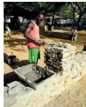
{ FIG. 3.55 } Nova construção, utilizando materiais maciços, como pedra, tijolo ou betão, que conferem inércia térmica aos edifícios. Este tipo de construção é adequado a climas quentes com amplitudes térmicas significativas entre o dia e a noite.
