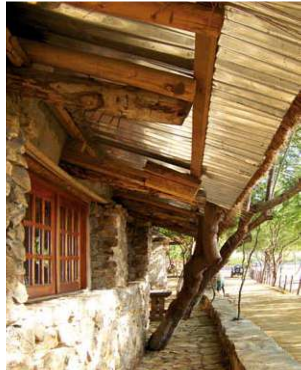
{ FIG. 3.29 } Sistema construtivo misto de cobertura. O colmo é sobreposto em chapa ondulada de material metálico (sub-capa): aos benefícios da impermeabilização e durabilidade conferidos pelo uso da sub-capa metálica adiciona-se a capacidade isolante do colmo.
