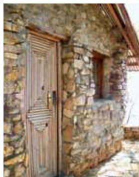
{ FIG. 3.55 } Nova construção, utilizando materiais maciços, como pedra, tijolo ou betão, que conferem inércia térmica aos edifícios. Este tipo de construção é adequado a climas quentes com amplitudes térmicas significativas entre o dia e a noite.
