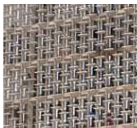
{ FIG. 3.15 } Utilização de dispositivos fixos para sombreamento ("Brise soleil"), num edifício modernista em Luanda.
