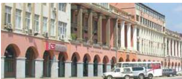
{ FIG. 3.20 } Sombreamento fixo: arcadas (esquerda, em baixo); projecção da cobertura (esquerda, em cima); e palas fixas num edifício comercial contemporâneo (direita).
