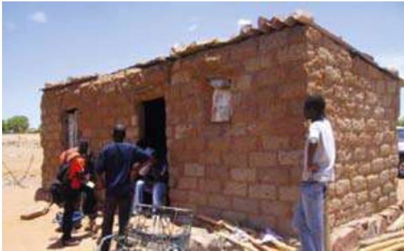
{ FIG. 1.8 } Construção não consolidada em espaço urbano: a edificação é normalmente executada pelo próprio, utilizando recursos locais (auto-construção).
