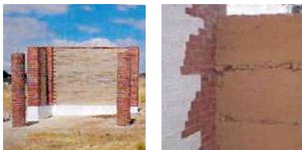
{ FIG. 7.2 } Técnicas de aplicação: Taipa.
