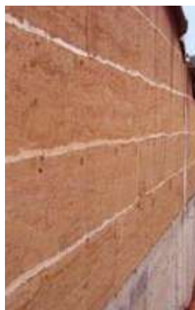
{ FIG. 7.4 } Construção em Terra: Taipa.
