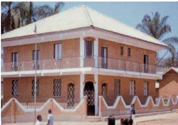
{ FIG. 7.3 } Habitação de construção em Terra, em Gabela.
