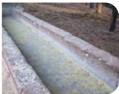
Cocho de concreto pré-moldado
