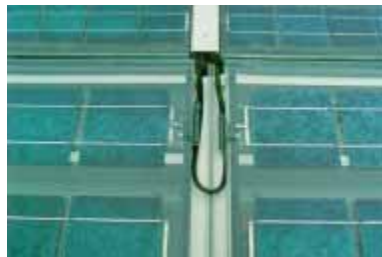
Figura 3.46 - Saída lateral dos cabos equipados com fichas de encaixe
