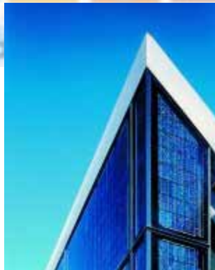
Figura 3.30 - Banco Rural de Bayer (Bayerische Landesbank) em Munique, Alemanha Módulos com células recortadas. Saint Gobain
