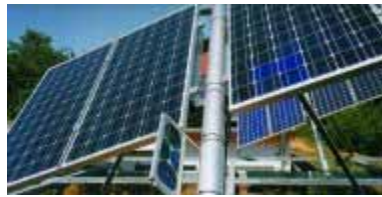
Figura 2.37 - Sistema de orientação solar com controlo eléctrico
