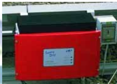
Figura 3.91 - Inversor de cadeia de módulos
