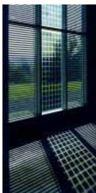
Figura 3.41 - Efeito de luz e de sombra provocado pelas células (janelas envidraçadas da esquerda e da direita). Os envidraçados do centro são módulos de vidro isolante com células solares POWER integradas
