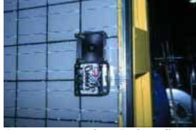
Figura 3.45 - Saída dos cabos com a caixa de junção do módulo no lado posterior
