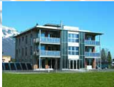
Figura 5.41 - Parque de demonstração de energias renováveis em Garms, Suíça. Parapeito do balcão: envidraçado vertical Módulo fixado na estrutura de ferro do corrimão
