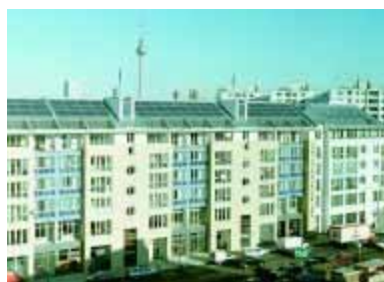
Figura 5.12 - Fachada fotovoltaica com módulos AC em Moritzplatz (Berlim)
