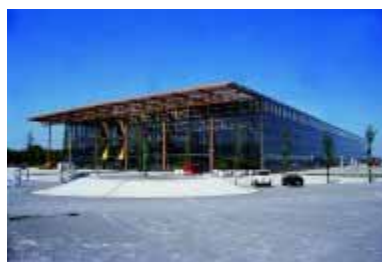
Figura 5.7 - Sistema fotovoltaico de 1 MWp da Academia de Ensino Superior em Herne (Alemanha)
