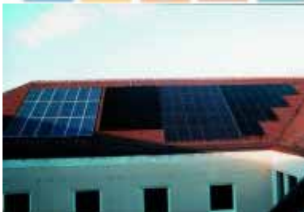
Figura 2.92 - Instalação fotovoltaica com módulos que utilizam várias tecnologias de células solares no Colégio Weihenstephan (Alemanha). Da esquerda para a direita: policristalino, monocristalino, CIS, amorfo, Telurieto de Cádmio, sendo cada um de aprox. 1 kWp Fotografia: Soltec
