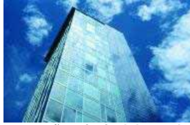
Figura 8.147 - Torre solar na estação principal de comboios de Freiburg, Alemanha
