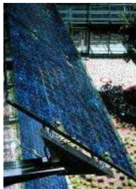
Figura 8.191 - Bayerische Landesbank em Munich Fixação pontual Xchüco Módulos vidro-vidro Saint Gobain
