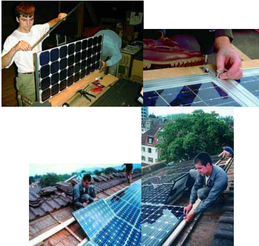
Figura 8.53 - Sequência de montagem das secções Solrif Fotografias: Enecolo
