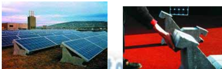
Figura 8.115 – Esquerda: Sistema de plintos de betão, com um par de plintos e de grampos de aço inoxidável por módulo e Direita: Plinto de betão Sofrel
