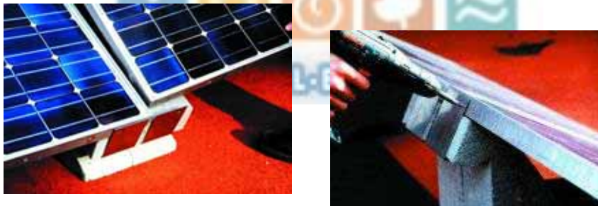
Figura 8.116 - Montagem de um módulo
