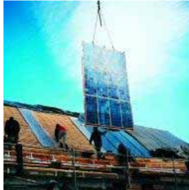
Figura 8.105 - Os módulos préfabricados são elevados num guindaste até a altura do telhado através de uma grua
