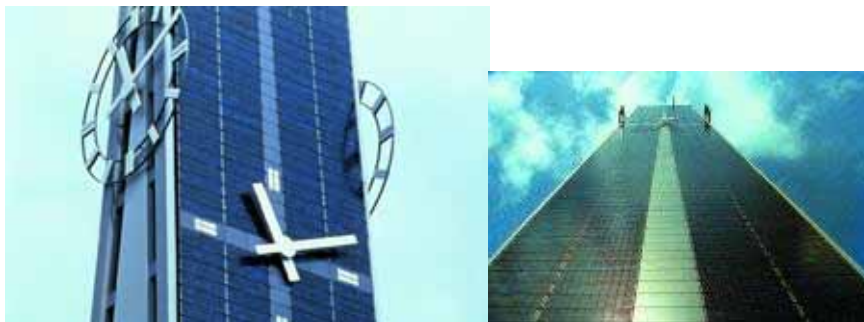
Figura 8.160 - Torre da igreja de Steckborn Fachada quente Módulos SunTechnics
