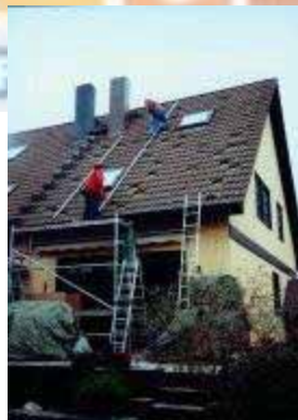
Figura 9.8 – Instalação dos ganchos do telhado
