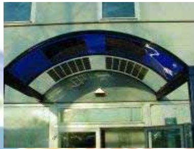
Figura 8.184 - Entrada de um casa Módulos de plástico acrílico Sunovation
