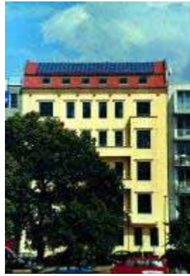
Figura 8.16 - Sistema fotovoltaico montado na Sede do Partido Federal Alemão dos Verdes, Berlim
