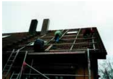
Figura 9.12 – Fixação das secções horizontais
