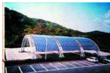
Figura 8.181 - Telhado da cobertura de um parque de estacionamento do Jardim Zoológico Kochi, no Japão Fotografia: NEDO
