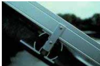
Figura 8.31 - Grampo entre dois módulos com armação
