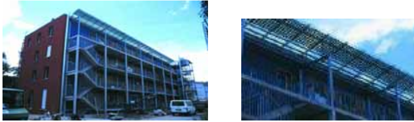
Figura 8.187 - Telhado sobre o passadiço de acesso de bloco residencial em Vauban, Freiburg, Alemanha Módulos vidro-vidro Saint Gobain
