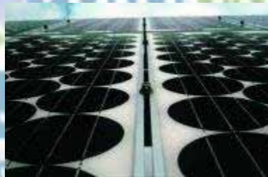
Figura 8.30 - Fixação lateral de um módulo com armação
