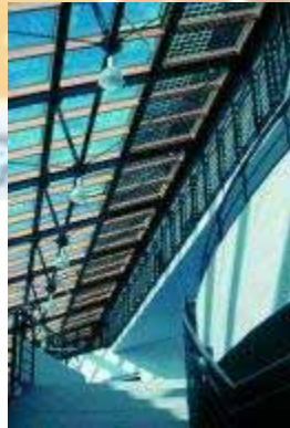
Figura 8.172 - Lar de terceira idade em Strassen, Luxemburgo Telhado quente Módulos de vidro isolante Saint Gobain Sistema montante/travessa Schüco
