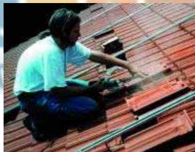
Figura 9.10 – Recorte das telhas
