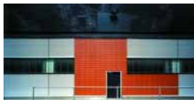
Figura 8.140 - Edifício da companhia de transporte Üstra em Hanover-Leinhausen, Alemanha Revestimento: módulos solares monocristalinos, telhas cerâmicas e placas onduladas de alumínio Fotografia: Solon AG, Gerhard Zwickert
