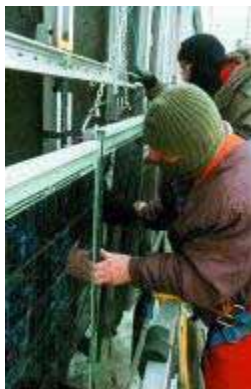
Figura 8.158 - Estrutura de suporte da fachada e fixação dos módulos
