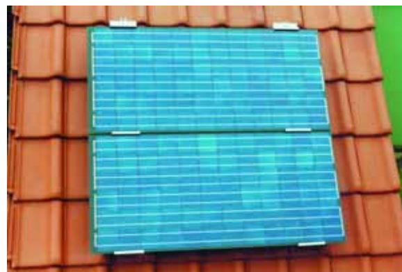
Figura 8.41 - Sistema Solar Universal Telha de fixação (em função do telhado) e montagem dos módulos da base para o topo Fotografias: Laumans
