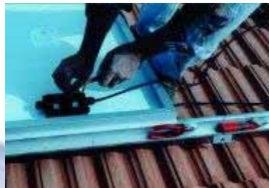
Figura 9.14 – Ligação dos módulos
