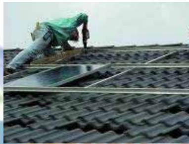
Figura 8.33 - Inserção dum módulo na secção horizontal AluTec
