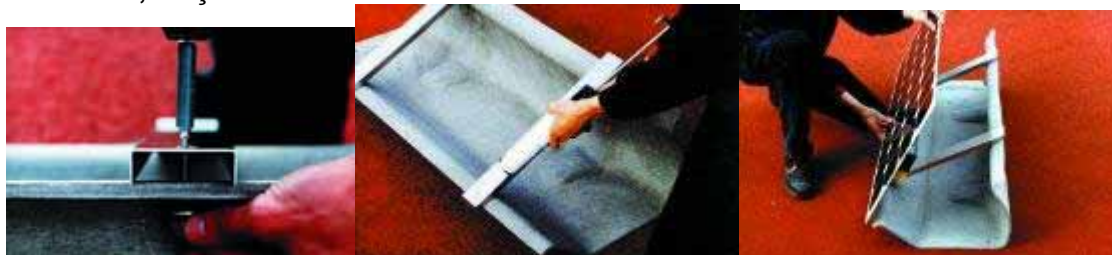
Figura 8.118 - Montagem de um laminado sem armação
