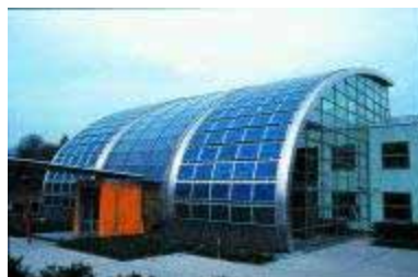
Figura 8.149 - Fábrica Shell Solarcell em Gesenkirchen, Alemanha
