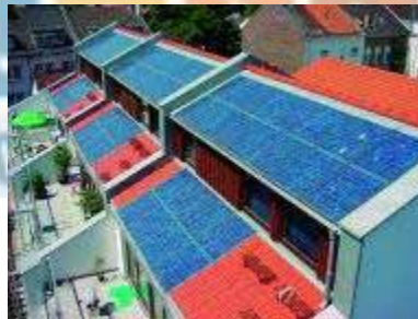
Figura 8.58 - Sistema de secções Energiedach Fotografias: Solarworld
