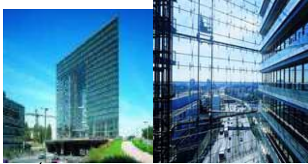
Figura 8.145 - Átrio do edifício “Stadttor” de Dusseldorf, Alemanha Envidraçado suspenso com sistema de fixações pontuais Estrutura: Ove Arup e Partners/Lavis Stahlbau Offenbach Fotografias: Werkfoto Gartner
