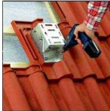
Figura 8.26 - Telha de fixação de alumínio
