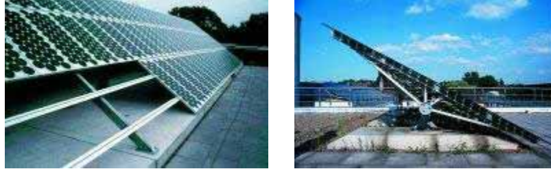
Figura 8.110 - Montagem num plinto de betão Montagem: (esquerda) Energiebiss
