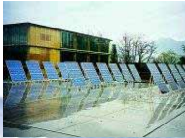
Figura 8.111 - Montagem sobre placas de betão Montagem: Stromaufwärts
