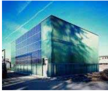
Figura 8.169 - Estação eléctrica Rieden no Lago Constância, Áustria Fachada fria Laminados com armação Kyocera Desenho Stromaufwärts
