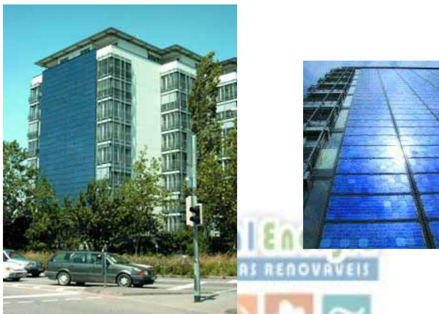
Figura 8.167 - Fachada recuperada de uma torre residencial em Freiburg, Alemanha Fachada fria
