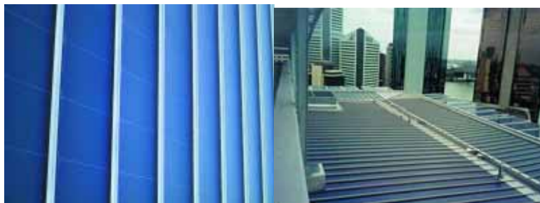
Figura 8.89 - Telhado de rebordo vertical SSR PV Fotografias: Bekaert ECD Solar Systems Europe
