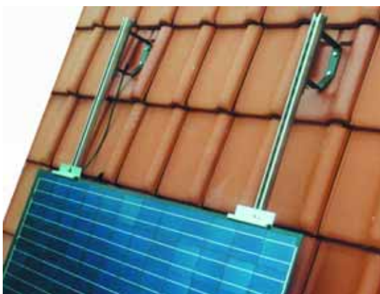
Figura 8.41 - Sistema Solar Universal Telha de fixação (em função do telhado) e montagem dos módulos da base para o topo Fotografias: Laumans
