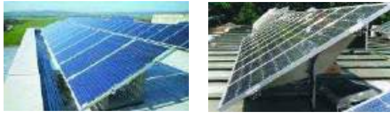
Figura 8.114 – Esquerda: Sistema de fixação em pedra, em L e Direita: Suporte ajustável, para as posições do Inverno e do Verão Montagens: Phönix Sonnenstrom e Schletter
