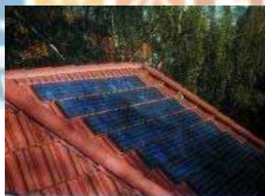
Figura 8.43 - Sistema de montagem Solo Fotografia: Solon
