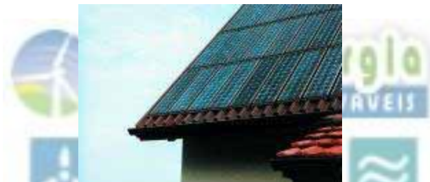
Figura 8.63: Módulos colados em placas trapezoidais Fotografia: PMS Energie AG
