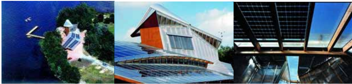
Figura 8.174 - Telhado quente Módulos de vidro isolante Saint Gobain Estrutura de madeira com suportes em aço e pinças em alumínio Schüco
