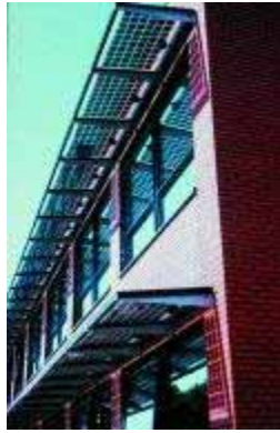
Figura 8.192 - Colégio Rembrandt em Veenendaal / Holanda Módulos vidro-vidro: Flabeg Estrutura de suporte Schüco
