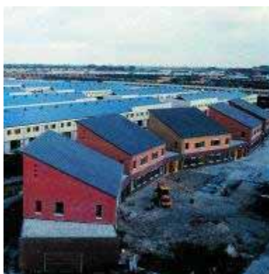
Figura 8.63 - 1 MW Residência Estatal 'Nieuwland', perto de Amersfoort, na Holanda, em primeiro plano, sistema Braas PV 700
