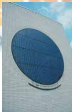
Figura 8.162 - Oficinas de EnergieNed em Arnheim, Países baixos Fachada fria Módulo Creaglas
