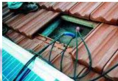
Figura 9.17 – Abertura no telhado para a passagem dos cabos das fileiras
