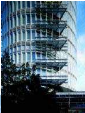
Figura 8.144 - Fachada de duplo revestimento folha: Sparkass 2000 em Pforzheim, Alemanha. Fotografia: Werkfoto Gartner
