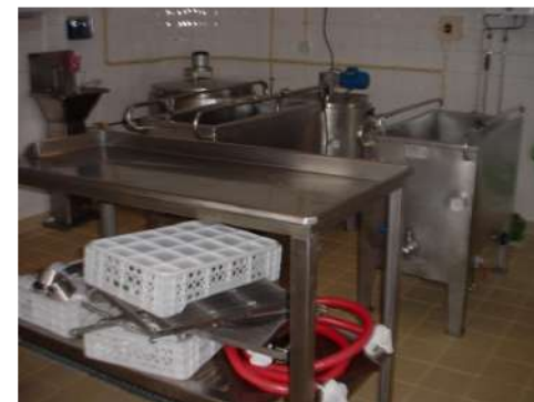
Aspecto geral de uma sala de fabrico
