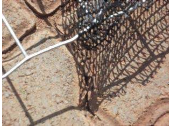
ILUSTRAÇÃO 55: TELA SOMBRITE (TENSIONADA EM TODOS OS SENTIDOS) ASSOCIADA À TELA DE AÇO ARAME 2.4
