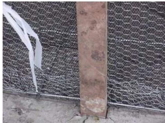
ILUSTRAÇÃO 56: TELA SOMBRITE + TELA DE AÇO ARAME 2.4 MAIS TELA HEXAGONAL 12 MM (1/2') ARAME 24)
