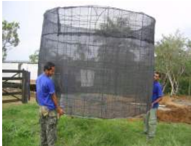
ILUSTRAÇÃO 45: ARMAÇÃO PARA RESERVATÓRIO DE 12000 LITROS (ARCABOUÇO TELADO)
