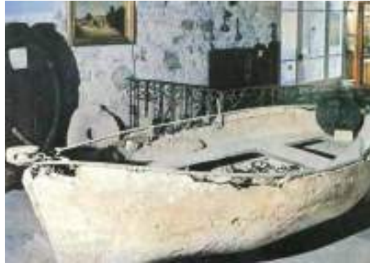
ILUSTRAÇÃO 1 – BARCO DE FERROCIMENTO DE LAMBOT (CONSTRUÍDO EM 1887)
