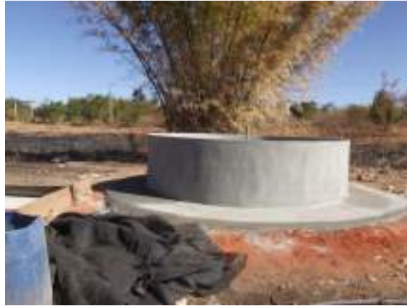
ILUSTRAÇÃO 7, 8 e 9: RESERVATÓRIO PARA PISCICULTURA
