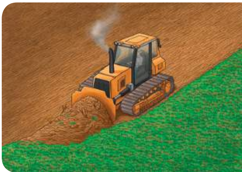
Raspagem da superfície do terreno
