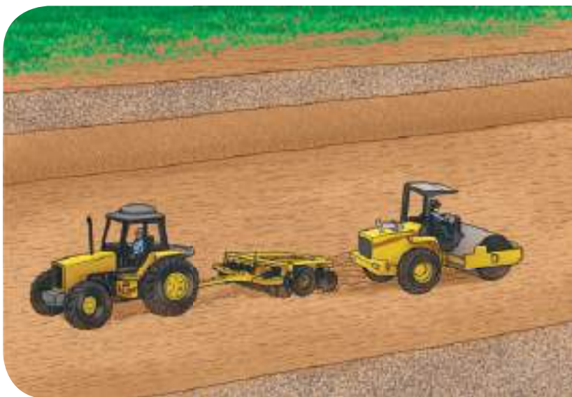
Solo compactado após o trator passar a grade
