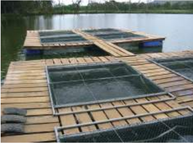
Figura 24 - Bateria de tanques-rede com plataforma
