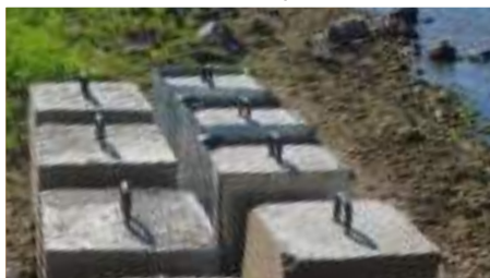
Figura 19 - Poitas de ancoragem
