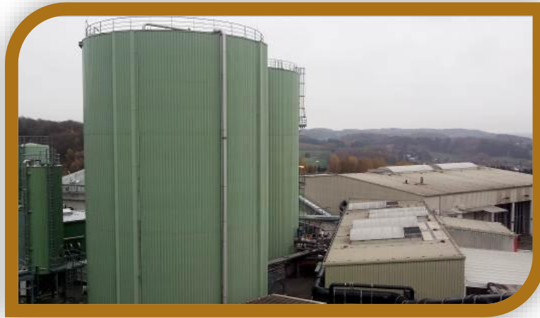
Biodigestores para tratamento de resíduos na Alemanha (acervo MMA)
