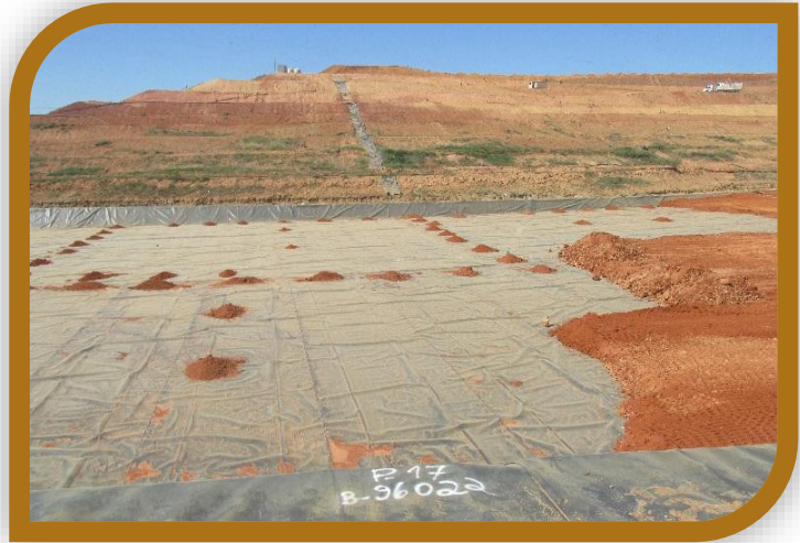
Aterro Sanitário em Paulínia/SP (acervo MMA)
