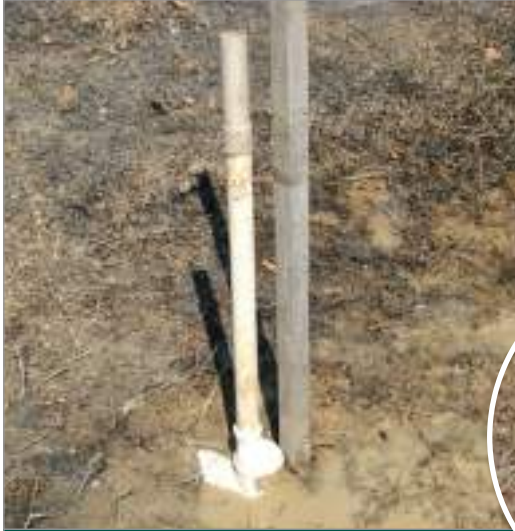
D) Tubo de esgotamento montado
