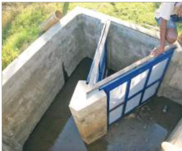
FIGURA 17 - Filtro para retenção de espécies indesejáveis à piscicultura e matéria orgânica, como folhas, galhos, entre outras
