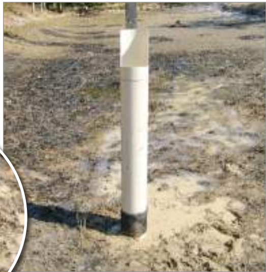
G) Cotovelo/cachimbo montado e fixo no fundo do viveiro
