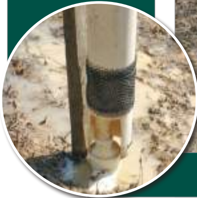
G) Cotovelo/cachimbo montado e fixo no fundo do viveiro
