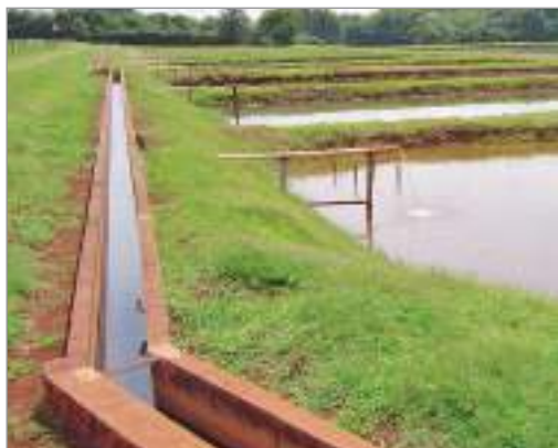
FIGURA 15 - Sistema de Abastecimento
