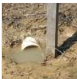
A) Tubo de 100mm aterrado e estaca de suporte do cotovelo/cachimbo
